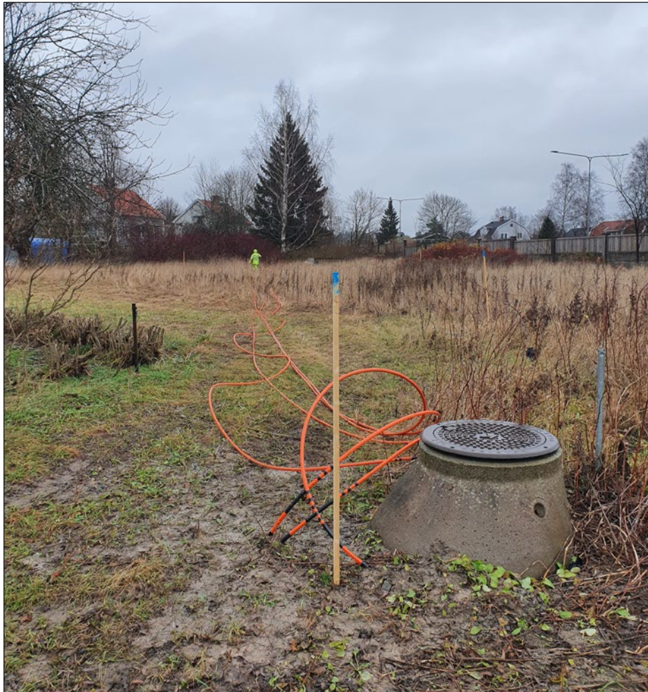
Figur 3. Översikt innan schaktningen påbörjades. Tänkt sträckning var från den brunn som syns i bildens nederkant och vidare mot den gran och björk som finns i bildens bakgrund. Foto från söder.
