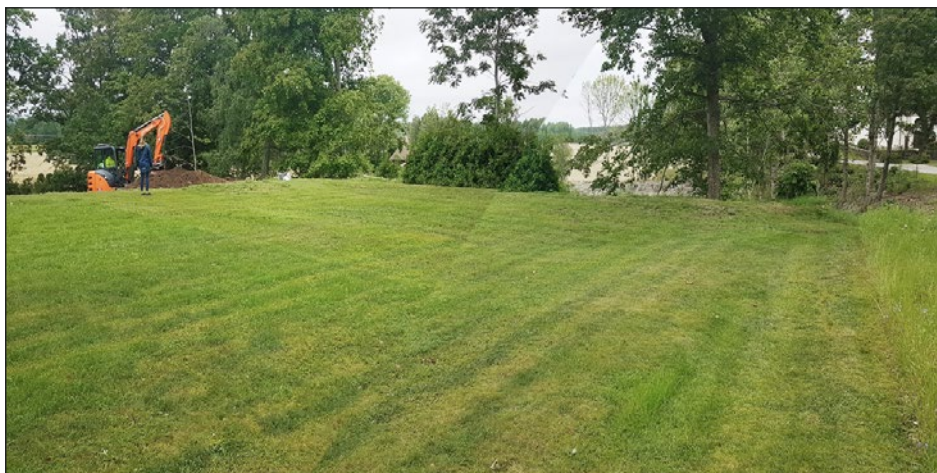
Figur 4. Vy över utredningsområdet sett från sydöst. Området utgjordes av en gräsmatta med en terrass i väster. Här ses grävmaskinen gräva schakt 1 i terrassen.
