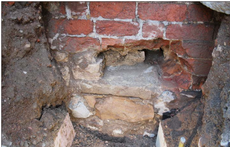
Figur 17. Det gamla hålet upprepansat. Foto från norr: Gustaf Palmhierta.
