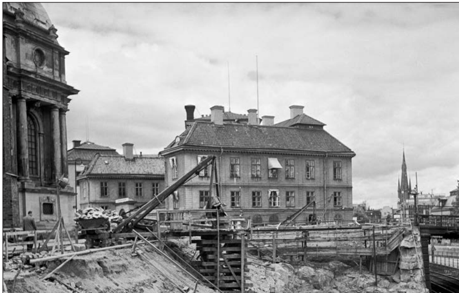
Figur 5. Tunnelgrävning pågår år 1951. Stadsmuseets arkiv: SSMSVD039203S.
