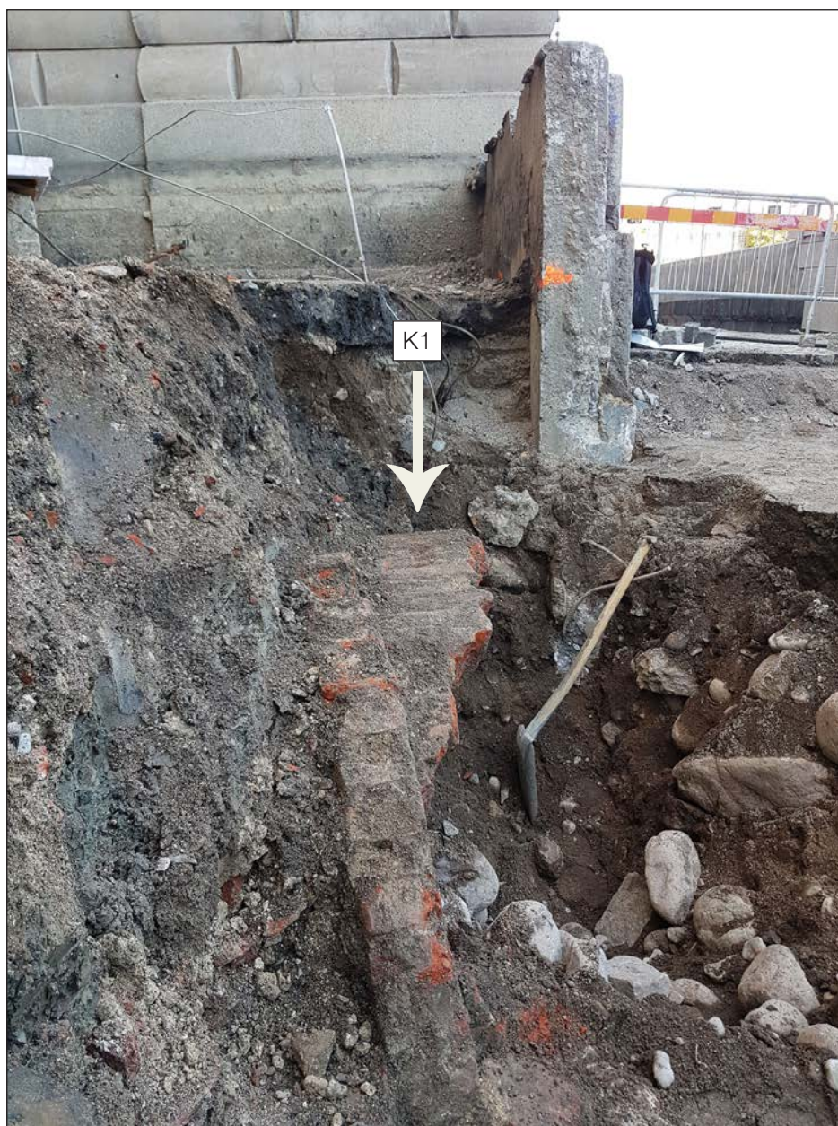
Figur 9. Stödmur av betong under rivning, Centralt syns källargången K1. Foto från söder.
