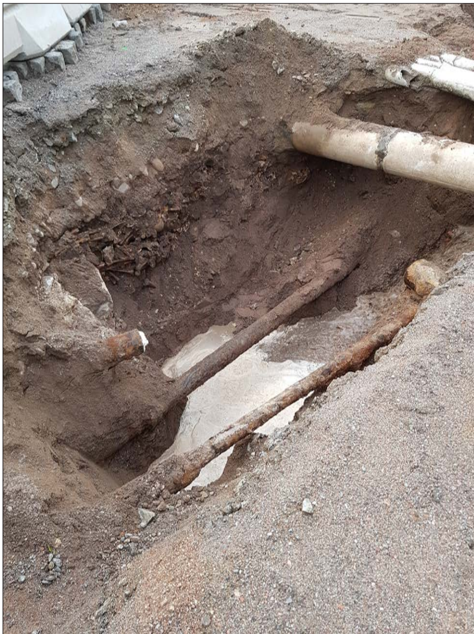
Figur 20. Bengrop, mur och massor av rör och kablar. Foto från söder.
