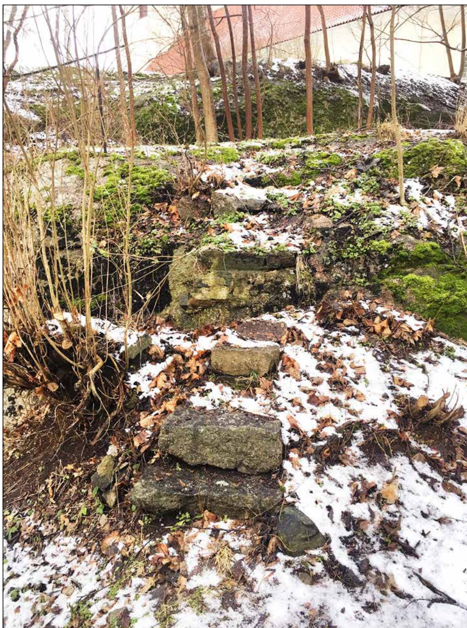
Figur 13. Den ovan omtalade trappan som leder upp på berget.
