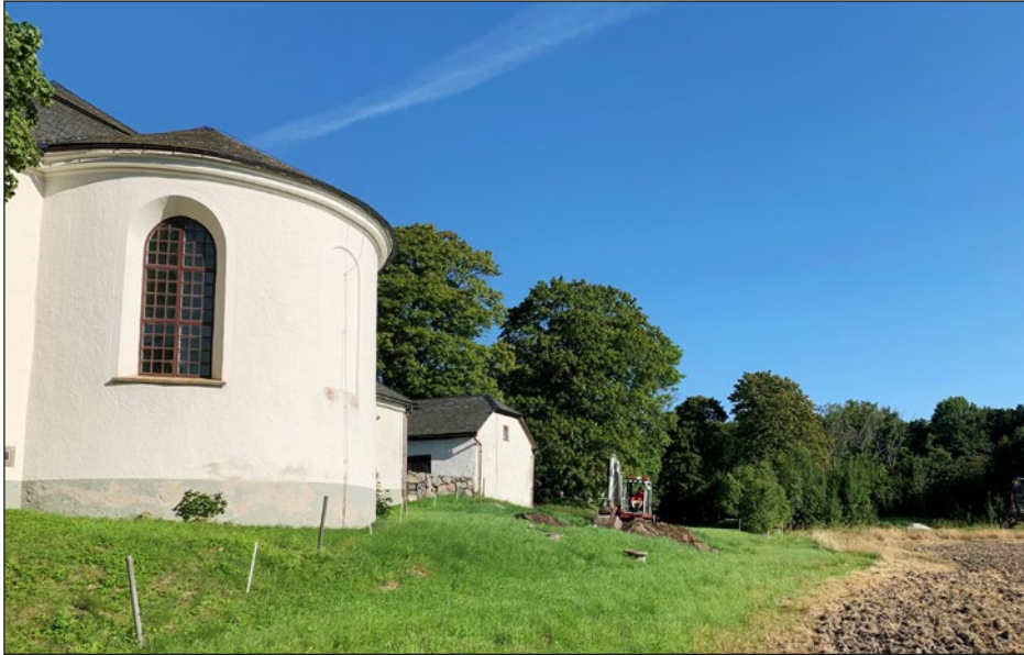
Figur 4. Schaktning pågår. Foto från sydöst.
