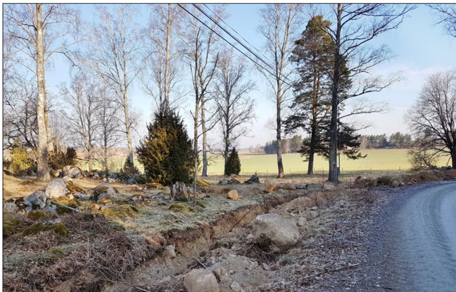
Figur 4. Sydvästra delen av schaktet. Foto från sydväst.
