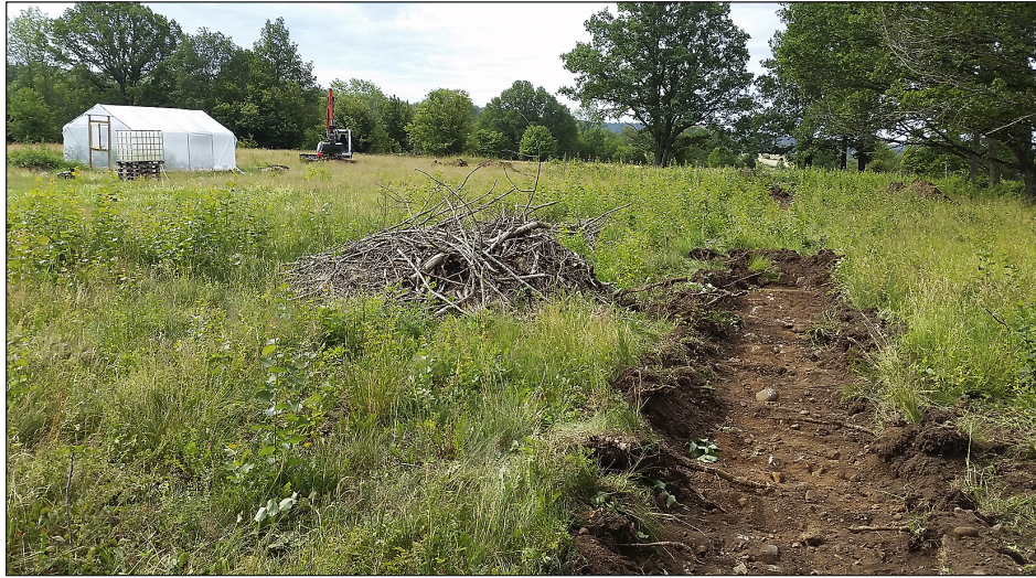
Figur 5. Schakt 6 i fögrunden och undersökningsområdet bortanför växthuset. Foto från norr.
