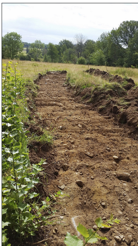
Figur 6. Schakt 10 bestående av 0,2 meter tjockt lager matjord med stenig morän i botten. Foto från väster.
