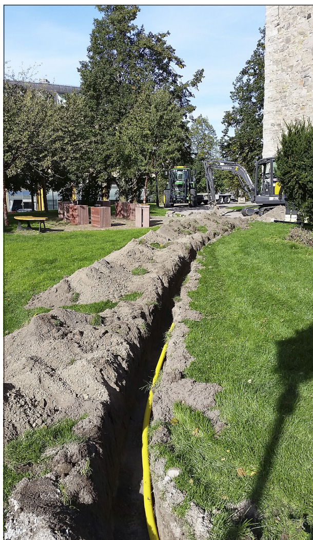
Figur 6. Norra delen av schaktet. Här påträffades inte det äldre marklagret. Under matjorden som var 0,3 meter tjock fanns grusig moränmark. Foto från sydöst.
