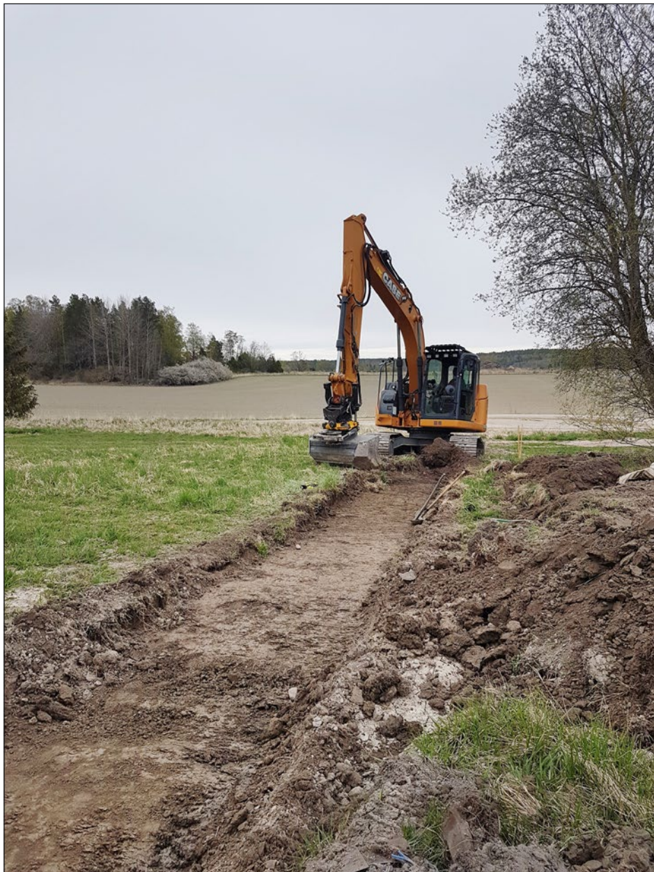
Figur 5. Schaktning sett från väster.
