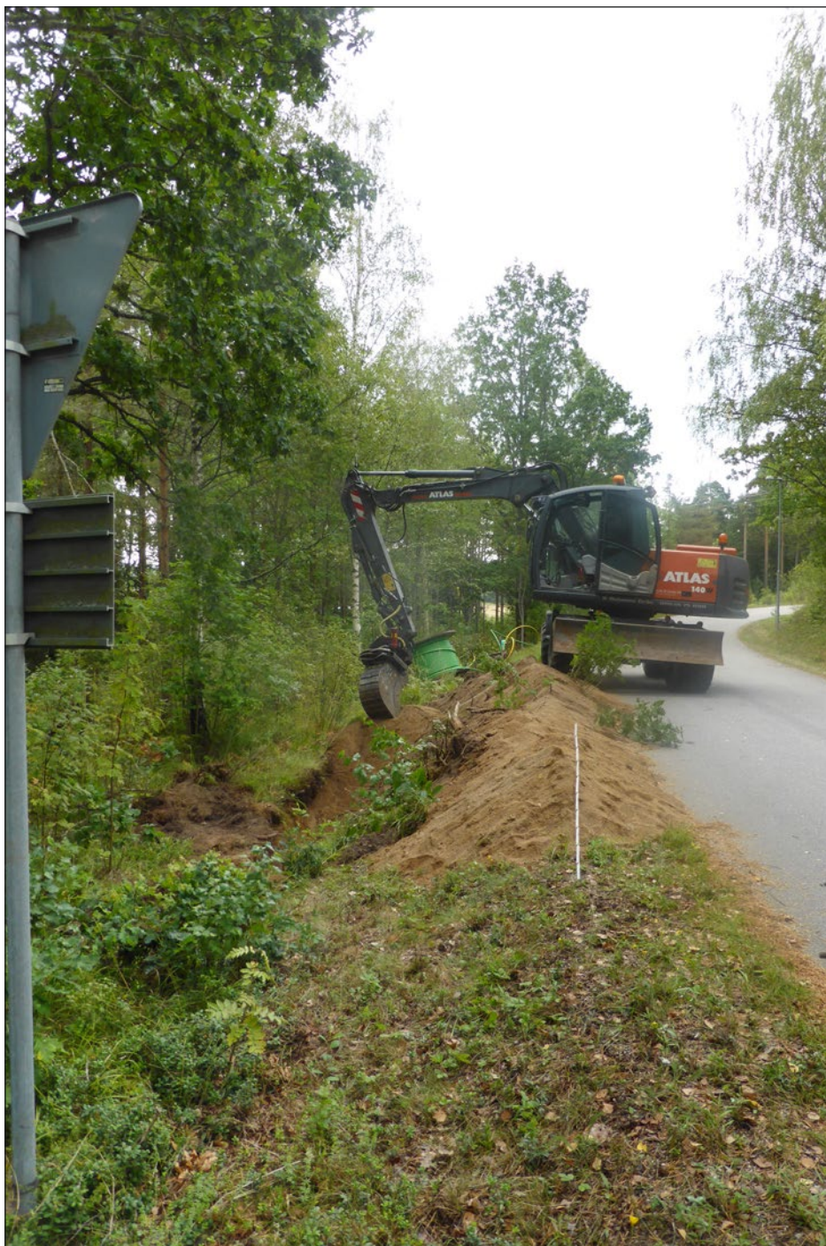
Figur 3. Vy över schaktet under grävning. Det placerades nedanför den uppbyggda branten vid vägen. Foto från norr.
