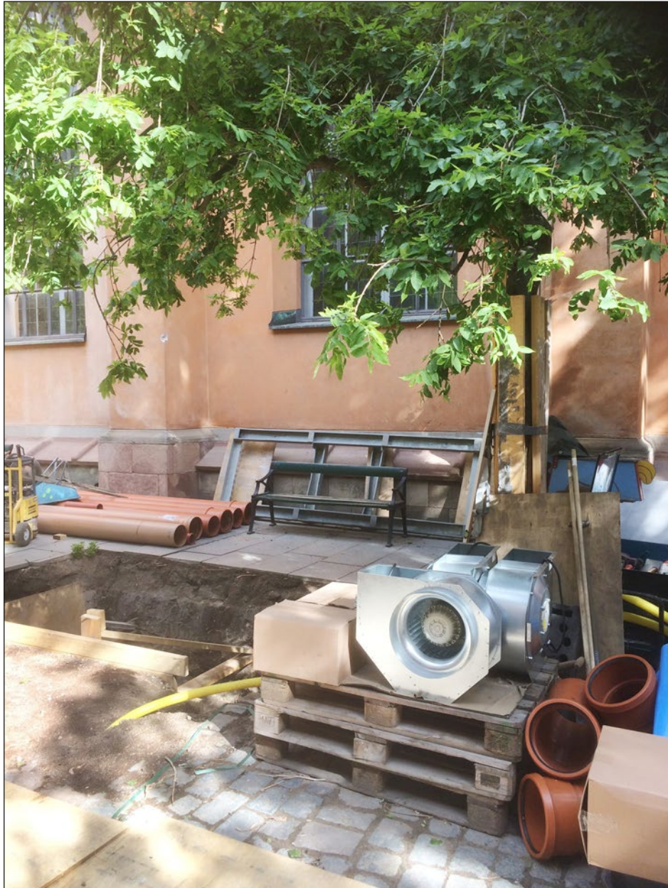
Figur 10. Inga fler gravar i grop 3. Fläkten till radonbrunnen väntar på schaktkanten.
