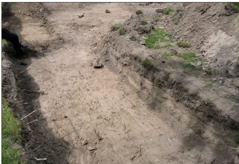
Figur 6. Det större schaktet i den norra delen. Området bestod av sandig mark, men överlagrades av ett upp till metertjockt matjordsskikt. I fyllningen fanns byggnadsrester från det hus (Ada) som flyttades till granntomten. Foto från söder.
