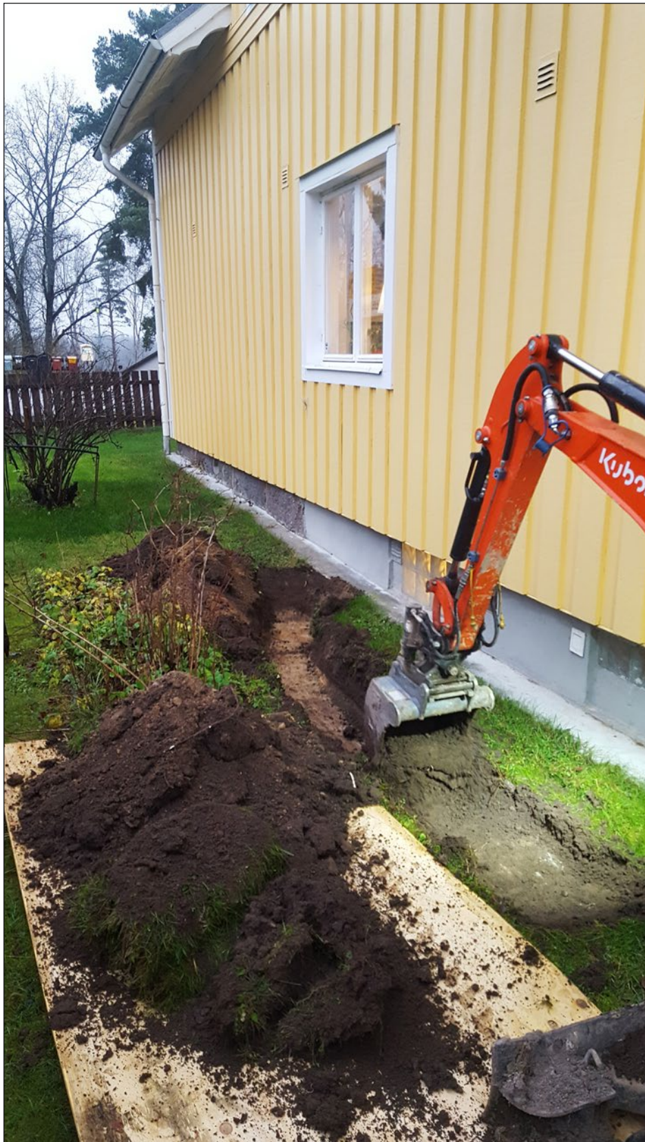
Figur 4. Grävning i anslutning till husgrunden. Foto från sydväst.
