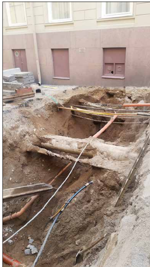
Figur 4. Schaktet med alla kablar och rör. Foto taget från nordväst.
