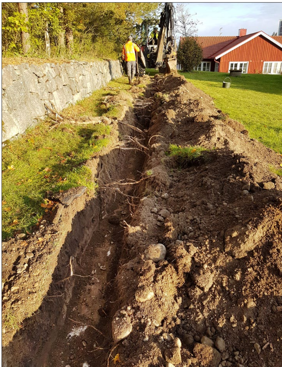
Figur 4. Översikt schaktets sträckning från söder.
