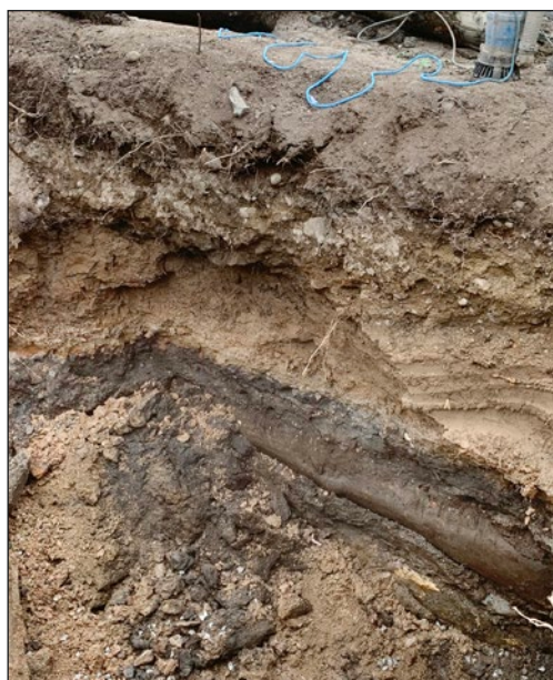
Figur 14 (t.h.). Schakt 3 färdiggrävt. I schaktväggen syns att timmerkistan A8 fortsätter mot söder. Foto från nordöst.
