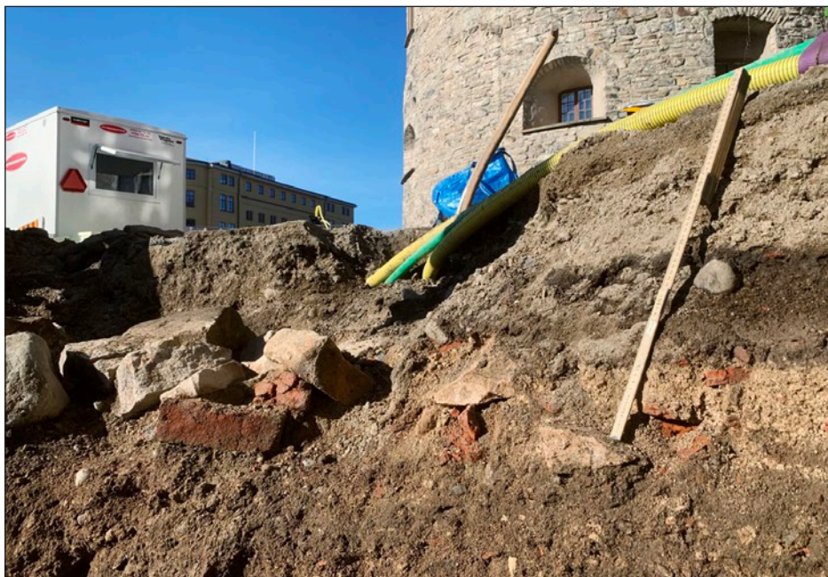
Figur 19. Lagerföljd centralt på terrassen. Mitt i schaktväggen syns det steniga lagret A2. Foto från öster.
