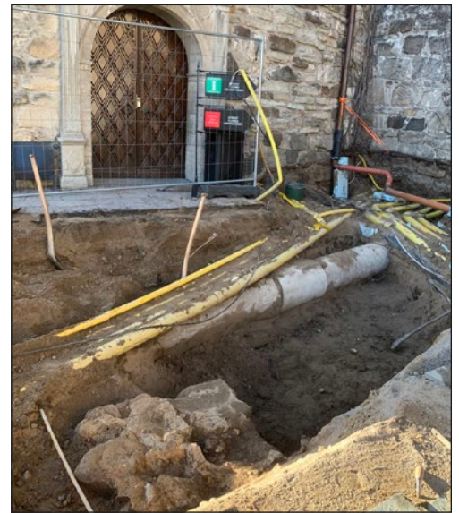
Figur 20b) Muren A3 i schakt S4. Foto från sydöst.
