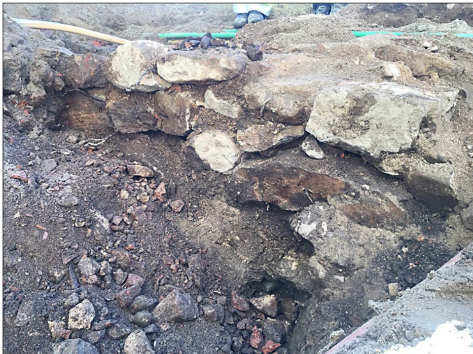
Figur 18. Muren A1 sedd från nordväst.
