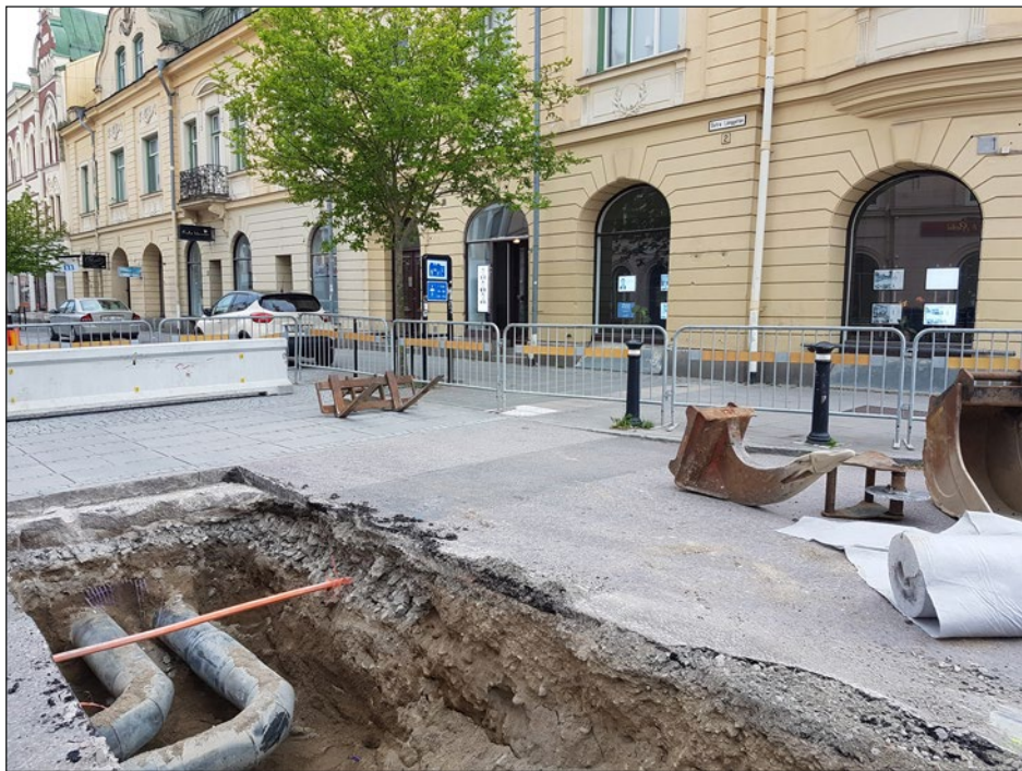
Figur 20. Schaktet i Östra Långgatan. Foto från norr.
