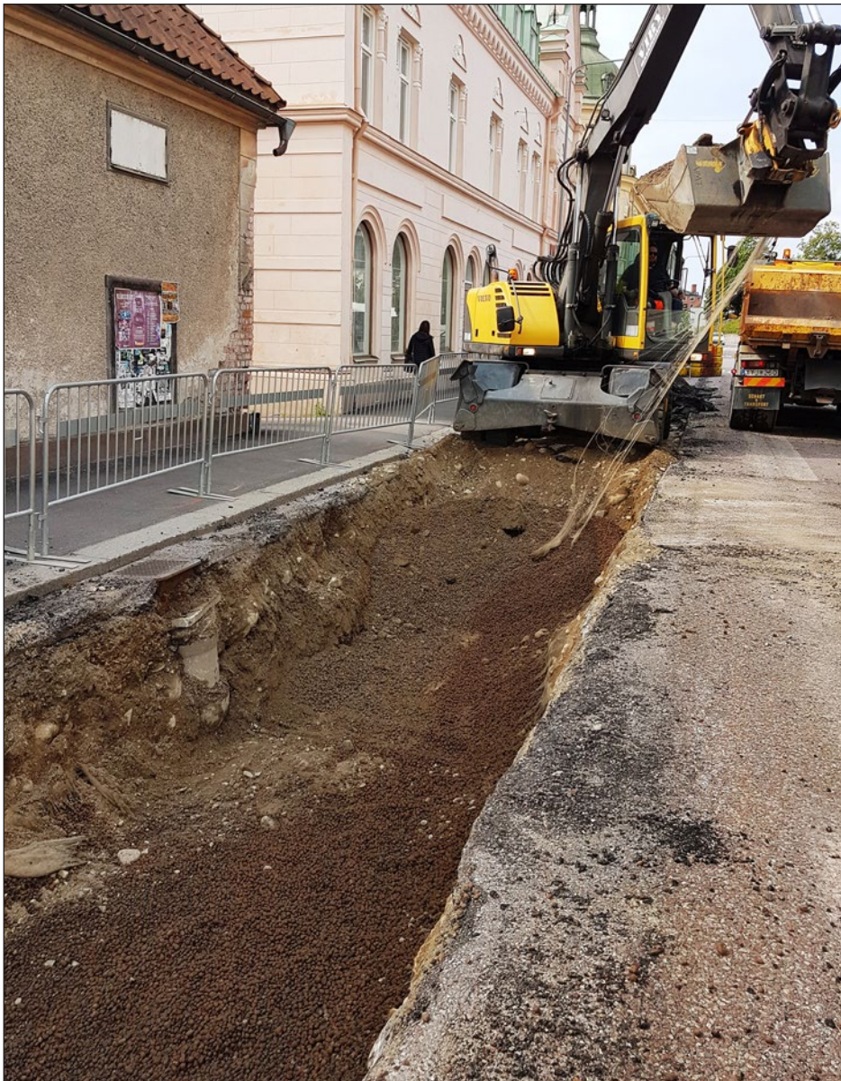
Figur 6. Den östra delen av schaktet med lecakulor mot botten. Sett från öst.
