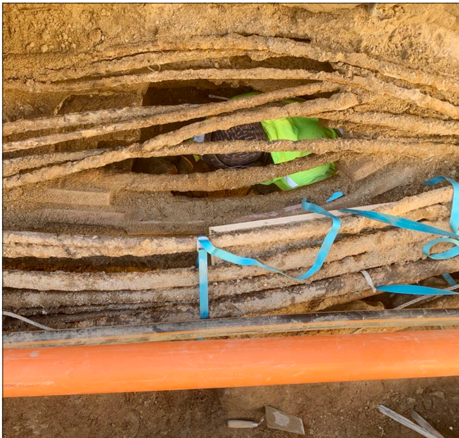
Figur 3. Handgrävning under elledningar pågår. Foto från öster.
