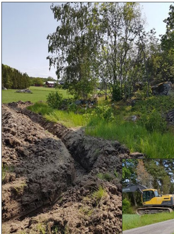
Figur 4. Schaktet längs med gravfältet med odlingssten i kanten. Sett från norr.
