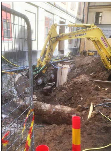
Figur 7. Schaktning på innergården. I förgrunden syns en del av den mur som framkom vid schaktningen (se även figur 5).
