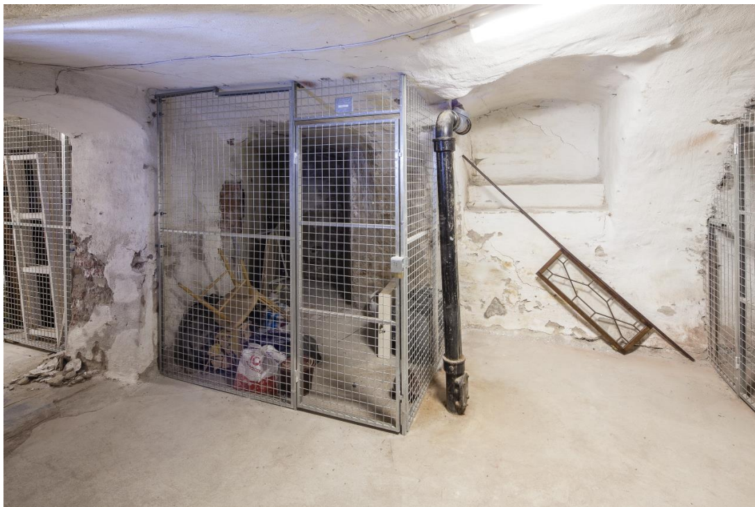
Figur 12. Sett från andra sidan av grundmuren leder en gång från det gallerförsedda förrådet ut mot skyddsrumsdörren. Till höger i bild syns vad som troligen utgör en igensatt trappa från gården till källaren. Foto: M.Ek. SSM1003547.
