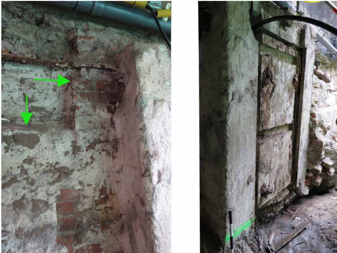
Figur 5a–b. Till vänster a) murpartiet till vänster om dörröppningens utskjutande omfattning. Två pilar markerar läget för en möjlig källartrappa från gården till gathusets källare. Till höger b) dörröppningen med ett dörrblad av stål. Foto: A.B, SSM10020996 och SSM1002094.
