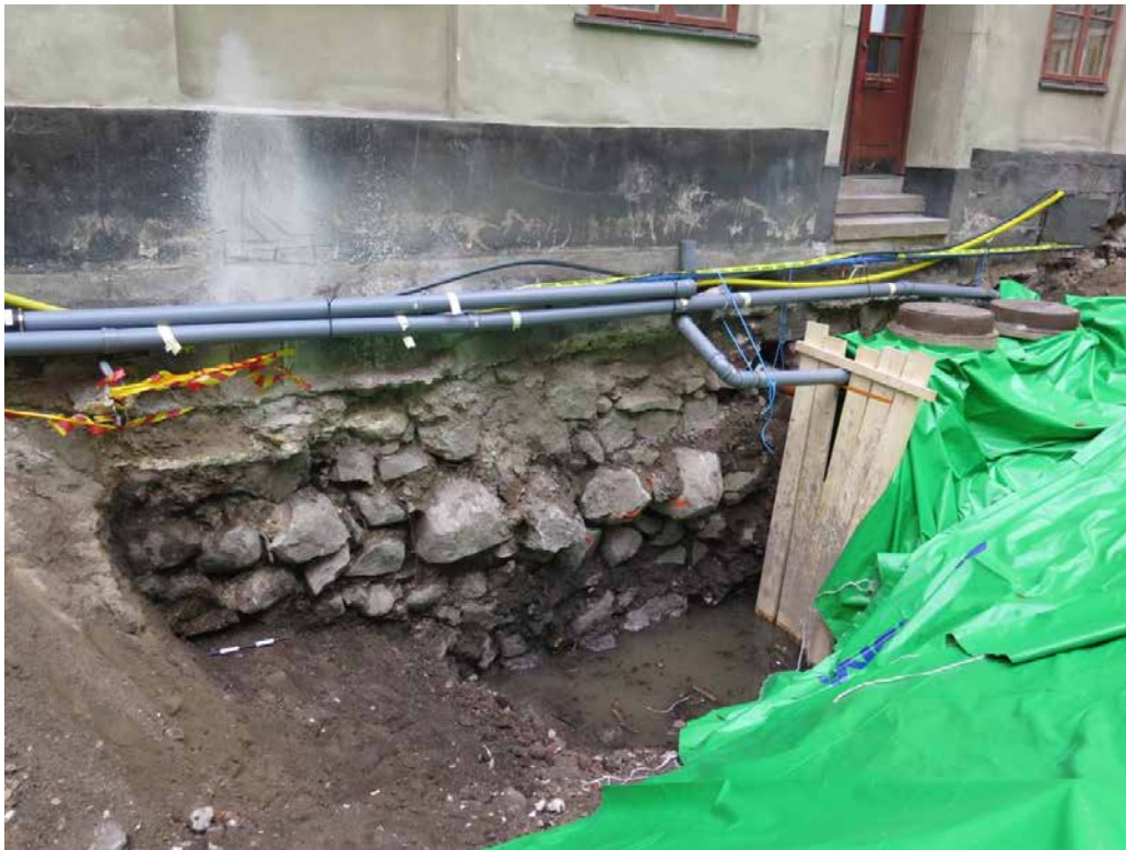
Figur 9. Grundmuren till Daedalus f d 4 sett mot öster. Till höger utanför bild löper Schönfeldts gränd. Skälstocken är 1 m lång. Foto: A.B, SSM10020992.
