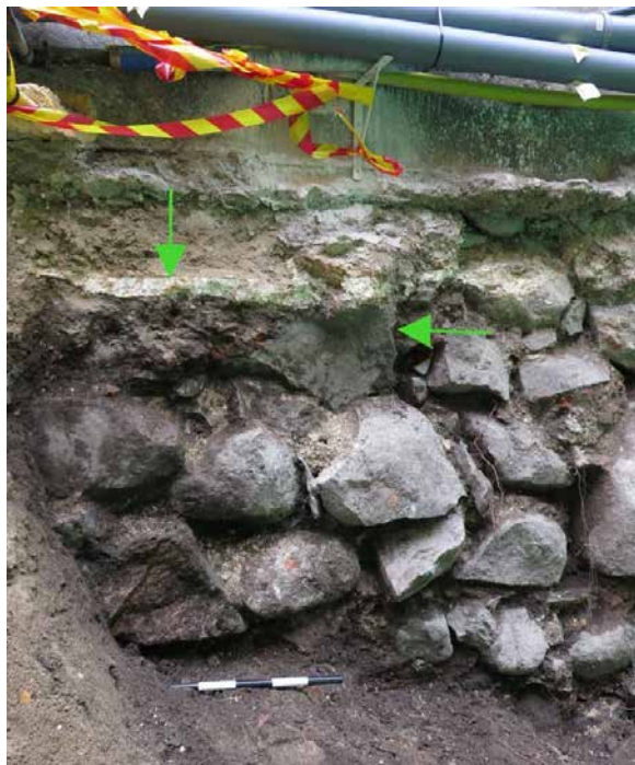
Figur 10. Detalj av grundmuren till Daedalus f d 4 där pilarna visar vad som förefaller vara injektering. Foto: A.B, SSM10020993.
