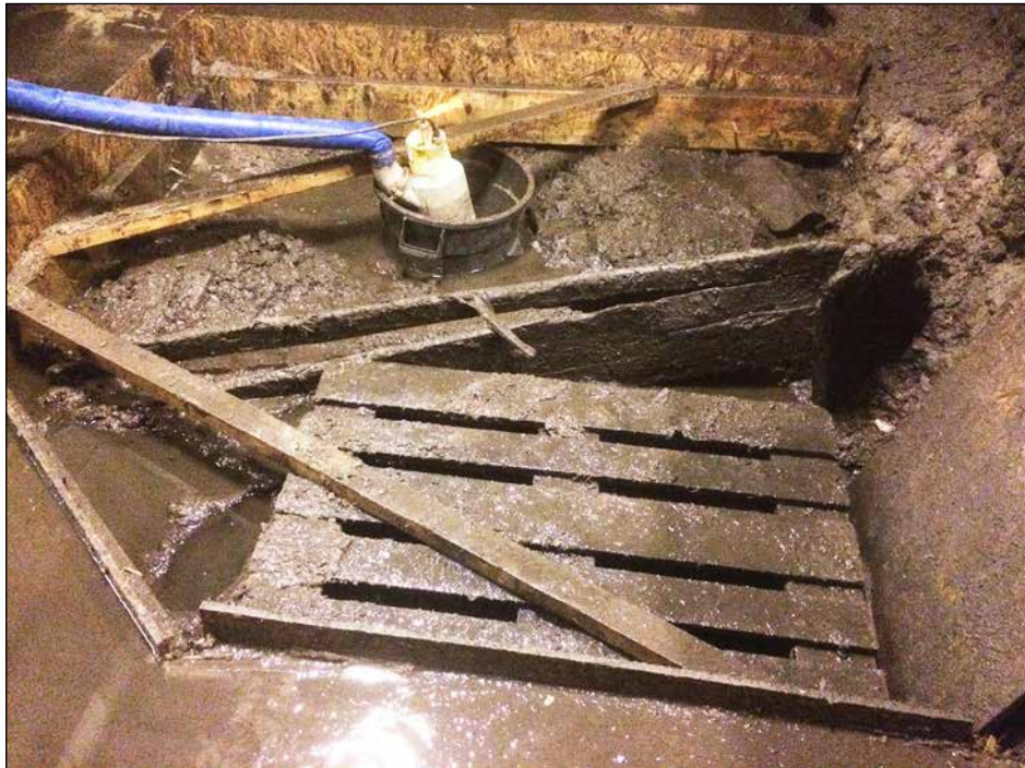
Figur 11. Miljöbild med träkonstruktion i rum C113.
