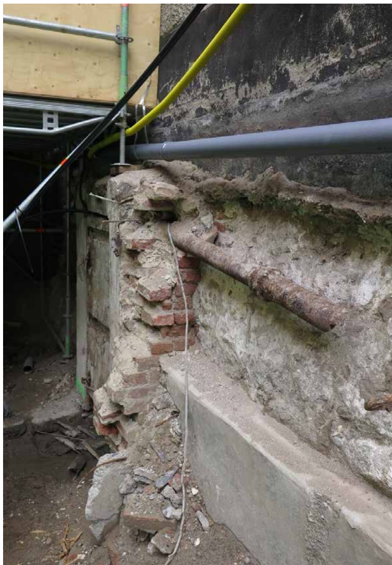
Figur 4. F d Daedalus 4. Grundmur och en rest av en sekundärt uppförd tegelmur, sett mot nordväst. Delar av muren var förstärkt med en betongsockel. Foto: A.B, SSM10020999.
