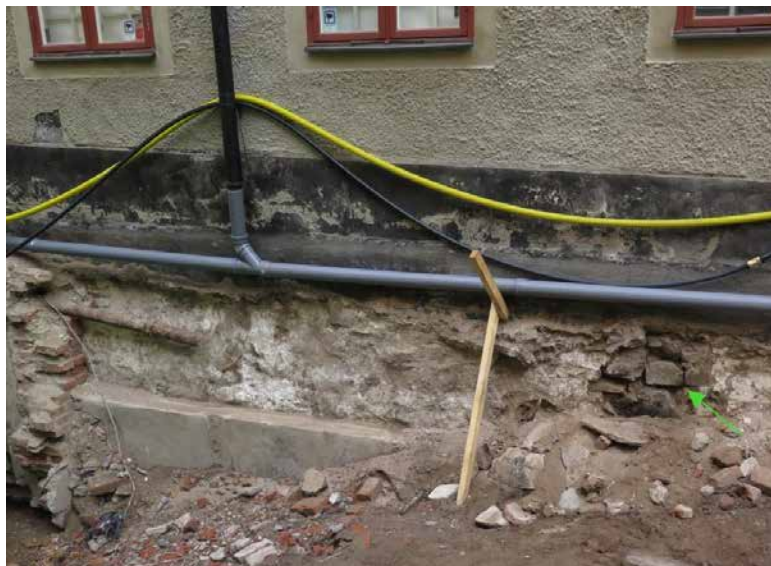
Figur 7. I grundmuren har två huggna stenar placerats sekundärt, markerade med en pil. Foto: A.B, SSM1002098.
