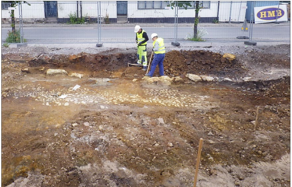
Figur 23. De två grunderna A25 och A30 under utgrävning, även stenläggningen och slaggpackningen A40 kan ses i förgrunden. Foto från sydväst.
