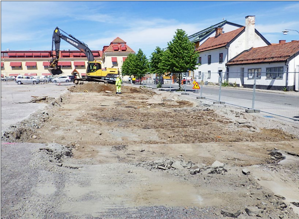
Figur 9. Den första inledande schaktningen. Foto från söder.
