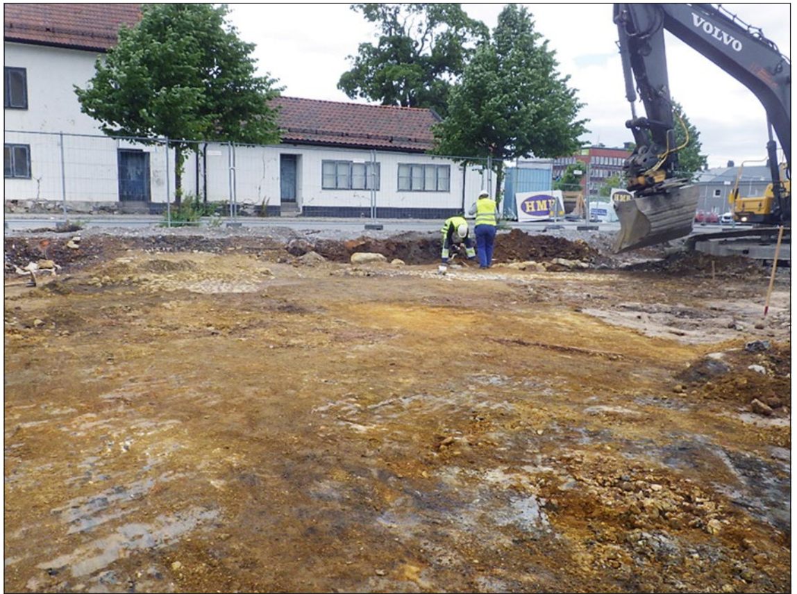
Figur 26. Den kombinerande sten- och slaggpäckningen A40, gårdsyta utanför anläggningarna A20 och 30 som dessutom täcker en stor del av undersökningsområdets norra del.
