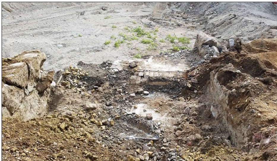
Figur 6. Källaren rensad. Foto från nordväst.
