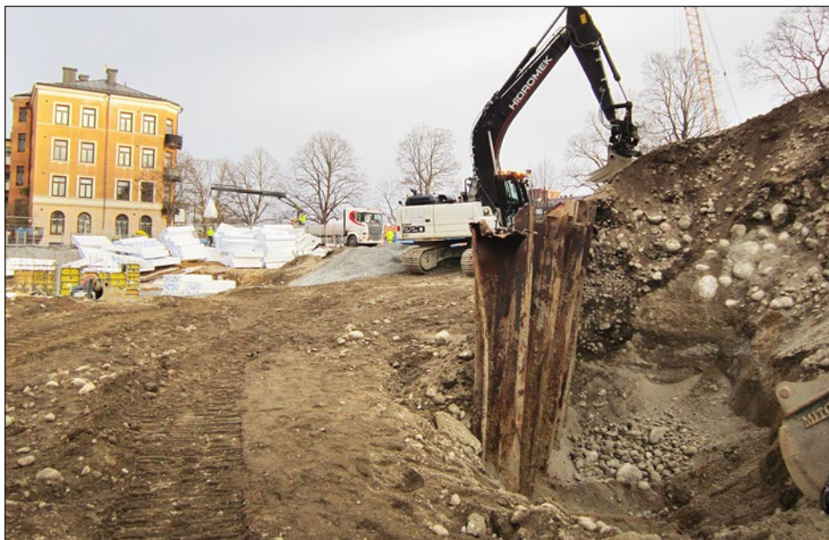
Figur 3. Schaktning pågår vid Orionkullen. Foto från söder.
