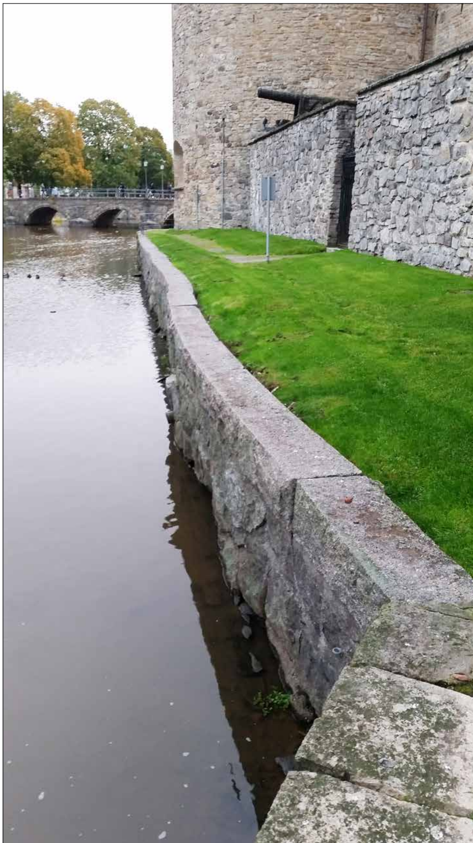
Figur 3. Strandmuren som omger slottet. Tidigare utgjorde terrassen till höger på bild den del av slottet som låg invid vattnet. På bilden syns även den utskjutande delen av strandmuren som skulle repareras. Foto från väster.
