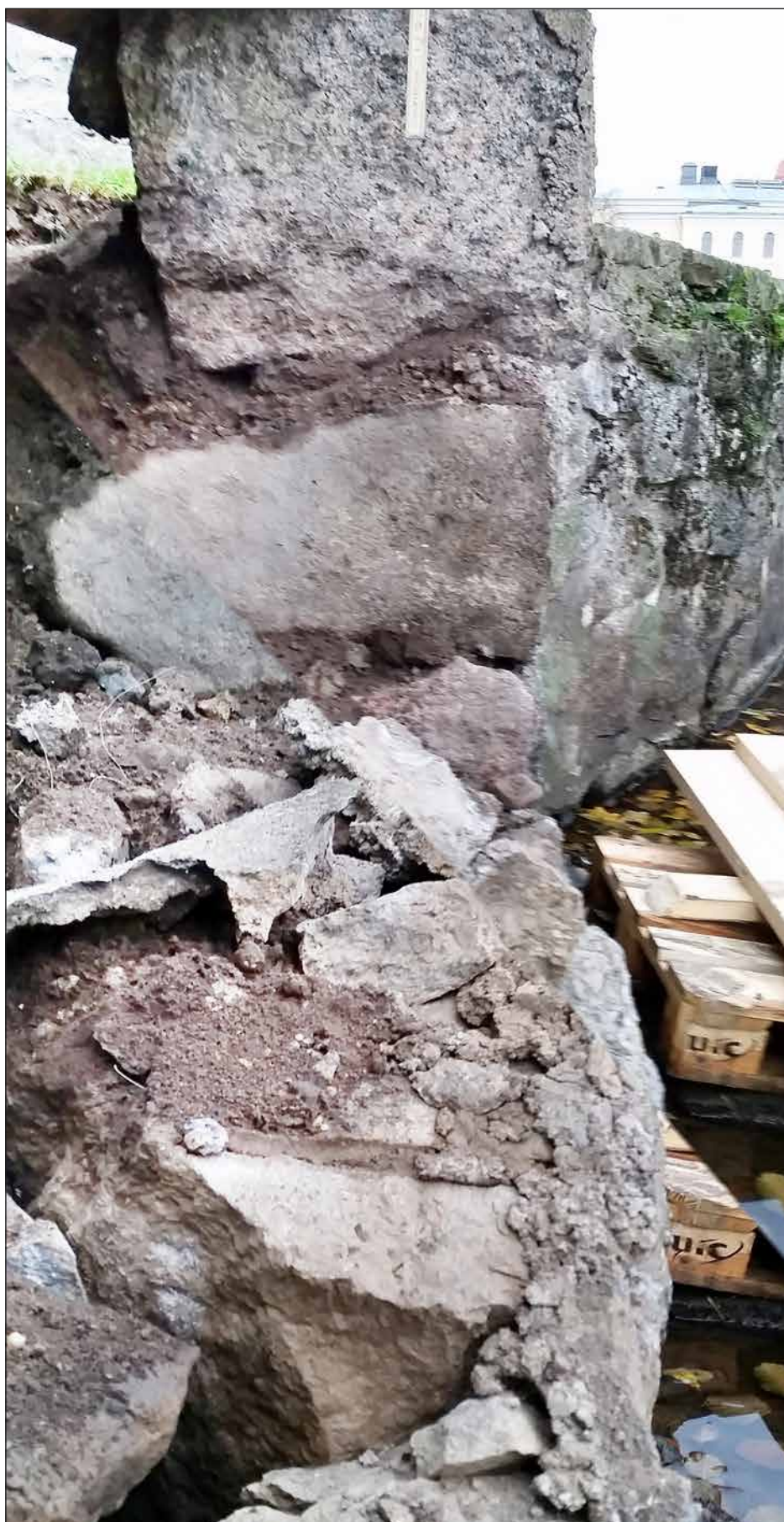
Figur 10. Profil som visar de två översta skiften. Emellan stenskiŧten finns packning med jord och inkilade flata stenskärvor. Foto från öster.
