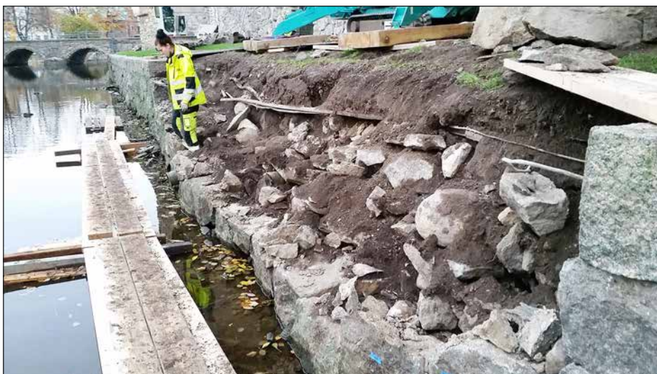
Figur 5. För att reparera den skadade delen av strandmuren bortplockades de tre övre skikten och jorden bakom muren grävdes bort för att senare fyllas igen med grus. Foto från väster.
