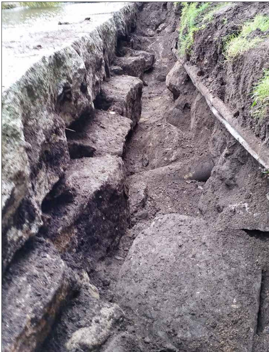
Figur 9. Till vänster i bild syns strandmurens två översta skikt. Till höger syns de påträffade kablarna samt delar av stenpackningen som låg bakom strandmuren. Foto från väster.
