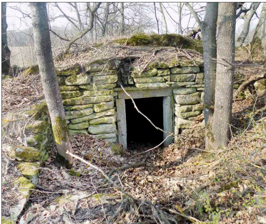
Figur 10. Källare (nr 4) sedd från öster.
