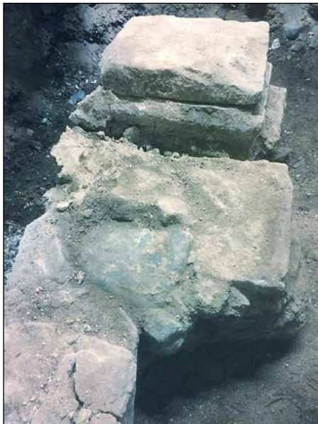
Figur 7. Fundament med skarv av gråstenar.
