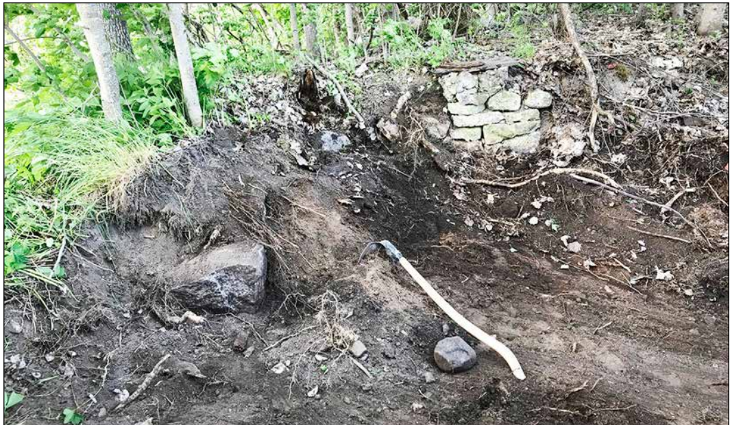
Figur 47. Kalkstensflis i den västra innerväggen.
