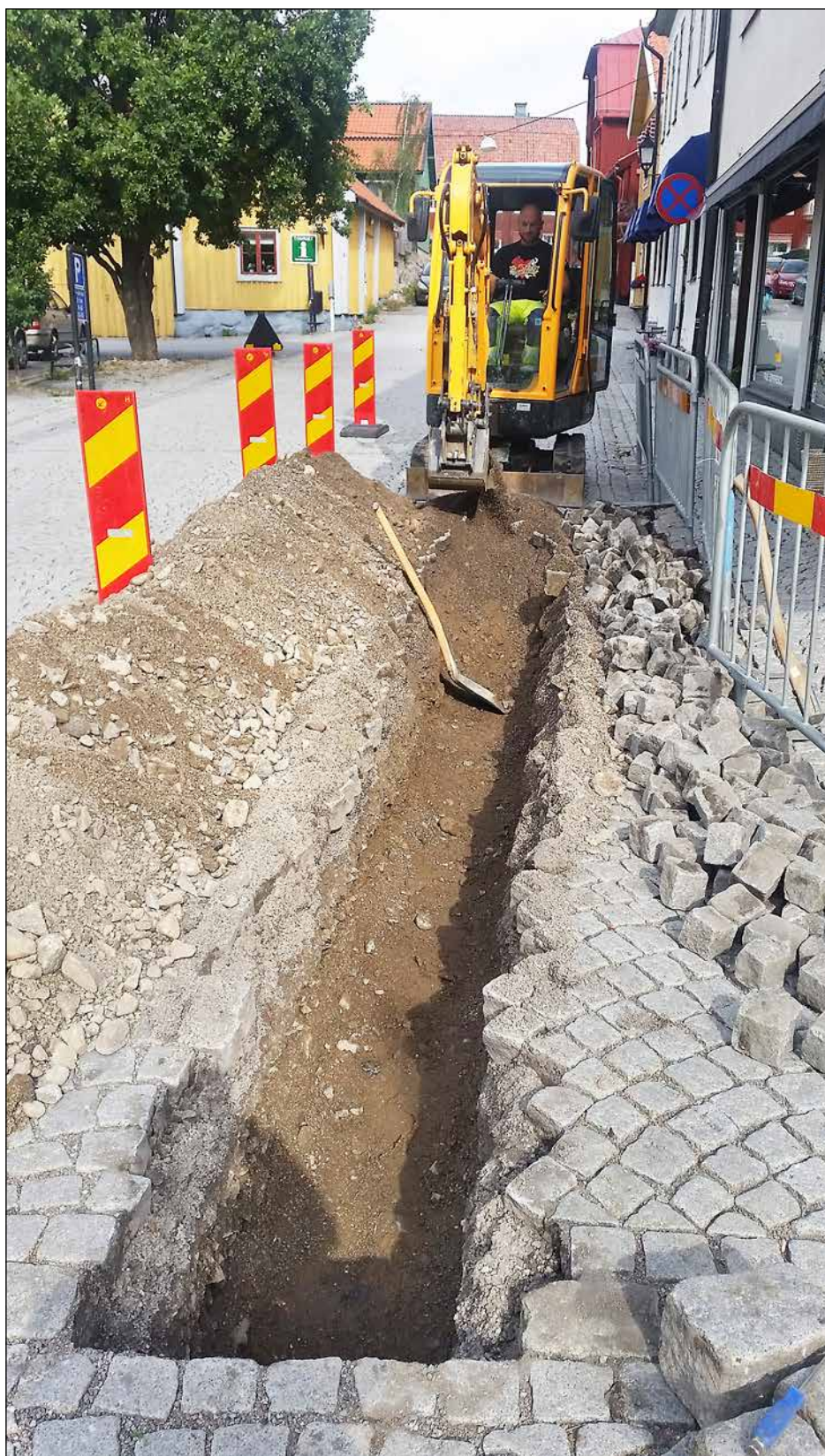
Figur 3. Schaktets södra del. Foto från söder.
