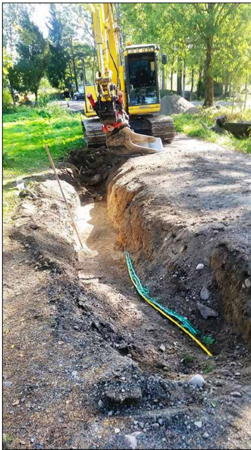
Figur 7. Schakt i område 2 med fiberkabel synlig i södra schaktkanten, från nordväst.
