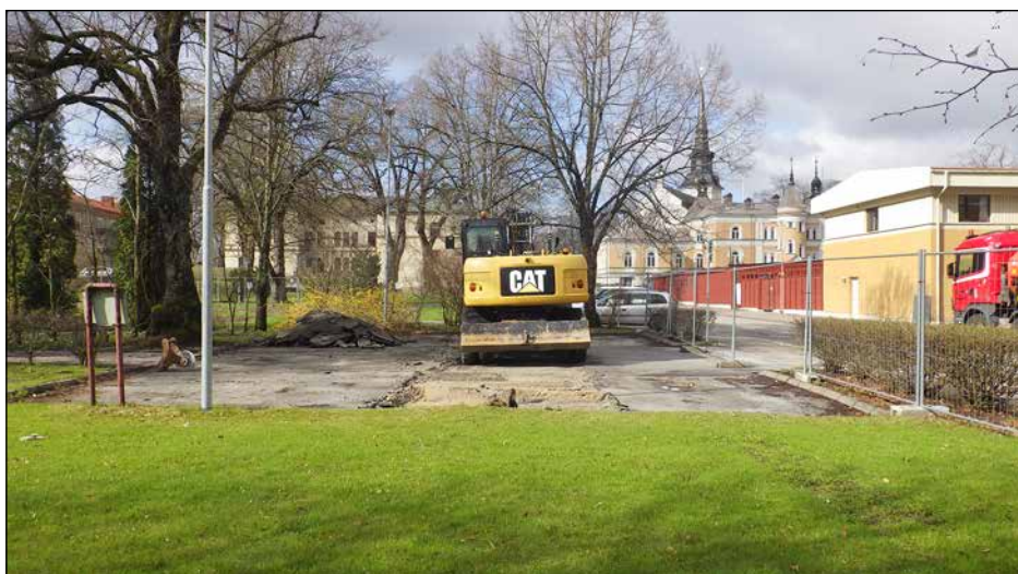
Figur 14. Östra delen av undersökningsområdet utgjordes av två asfalterade parkeringsplatser omgivna av träd. Här syns den norra parkeringen. Foto från öster.
