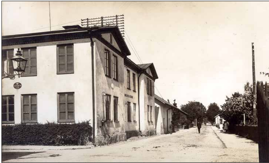
Figur 9. Telegrafverkets byggnad invid Kristinavägen. Foto från tidigt 1900-tal. Raseringsmassor efter denna byggnad påträffades i schakt 504.
