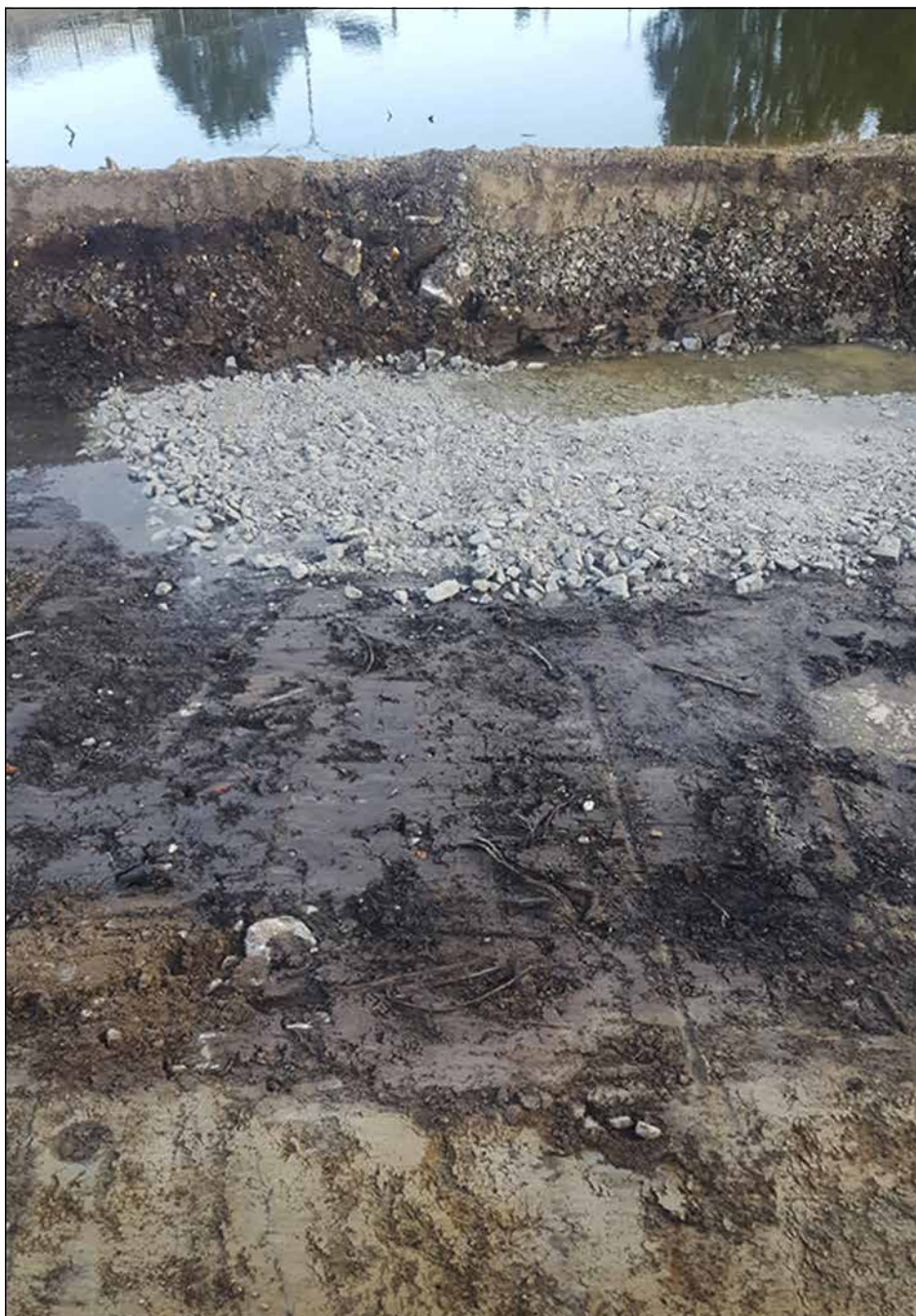
Figur 7. Gränsen mellan den naturliga leran och i ån utfyllda partier.
