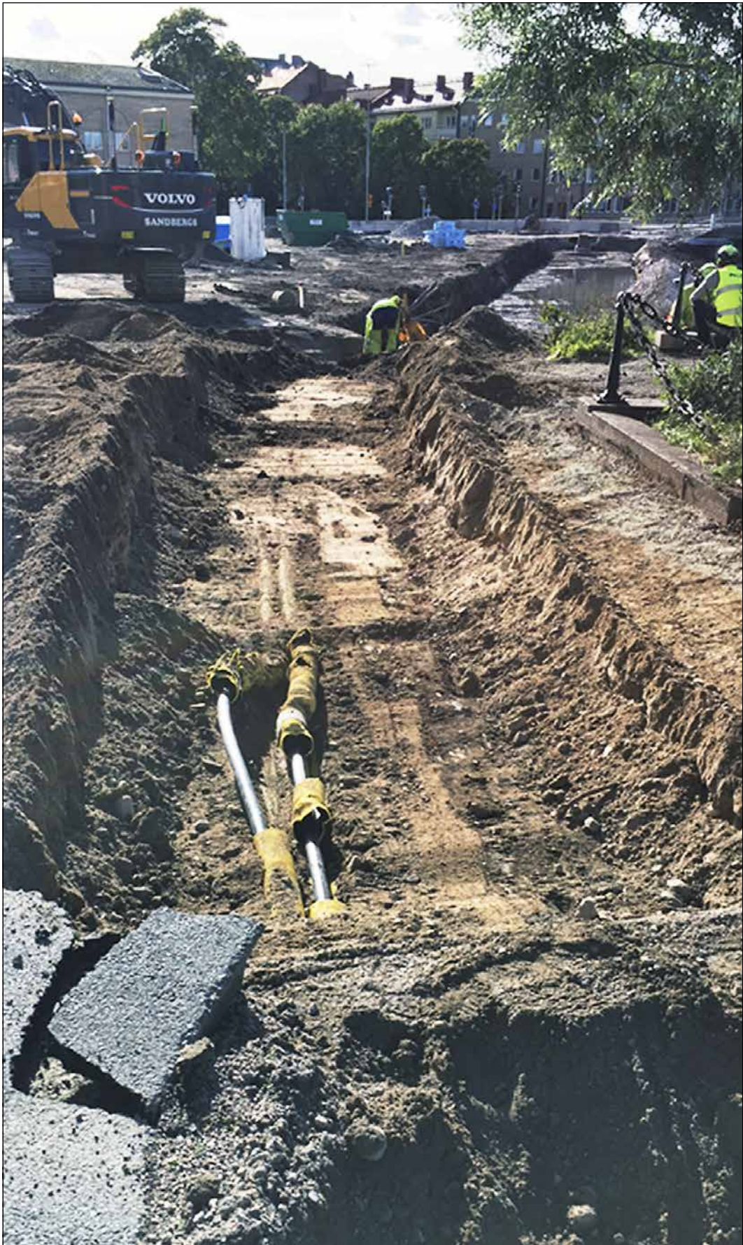
Figur 4. Sedan tidigare nergrävda ledningar i schaktets östra del.
