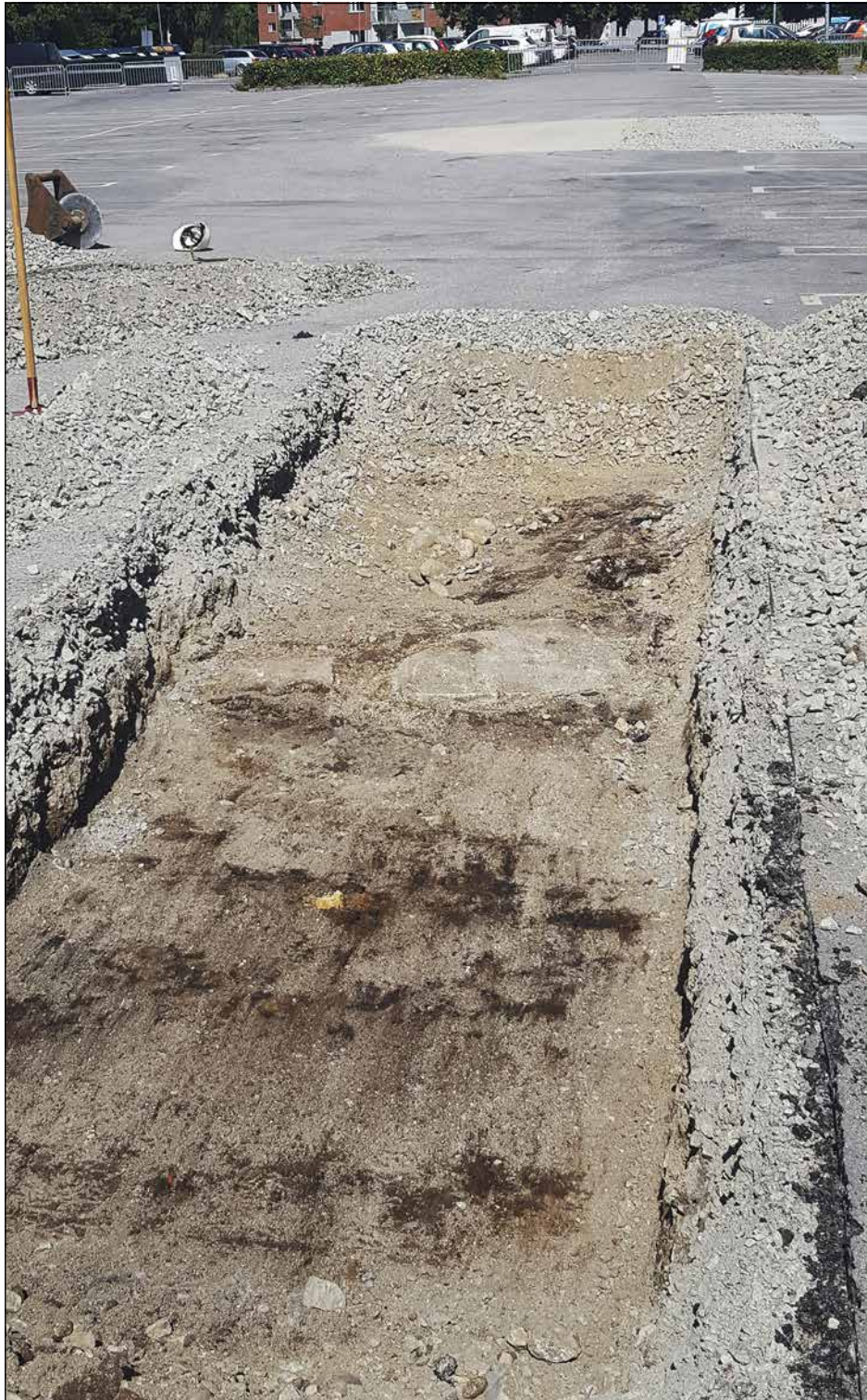
Figur 3. Översikt Tunadalsparkeringen med schakt S254 i förgrunden. På bilden har endast asfalt och bärlager för asfalten tagits bort. Foto från söder.
