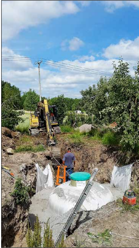
Figur 4. Schaktet sett från sydöst.
