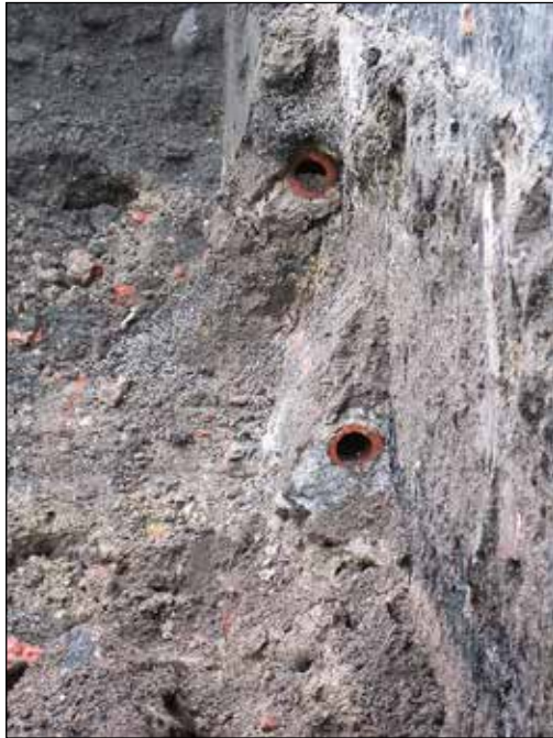
Figur 14. Två parallella tegelrör för dränering.
