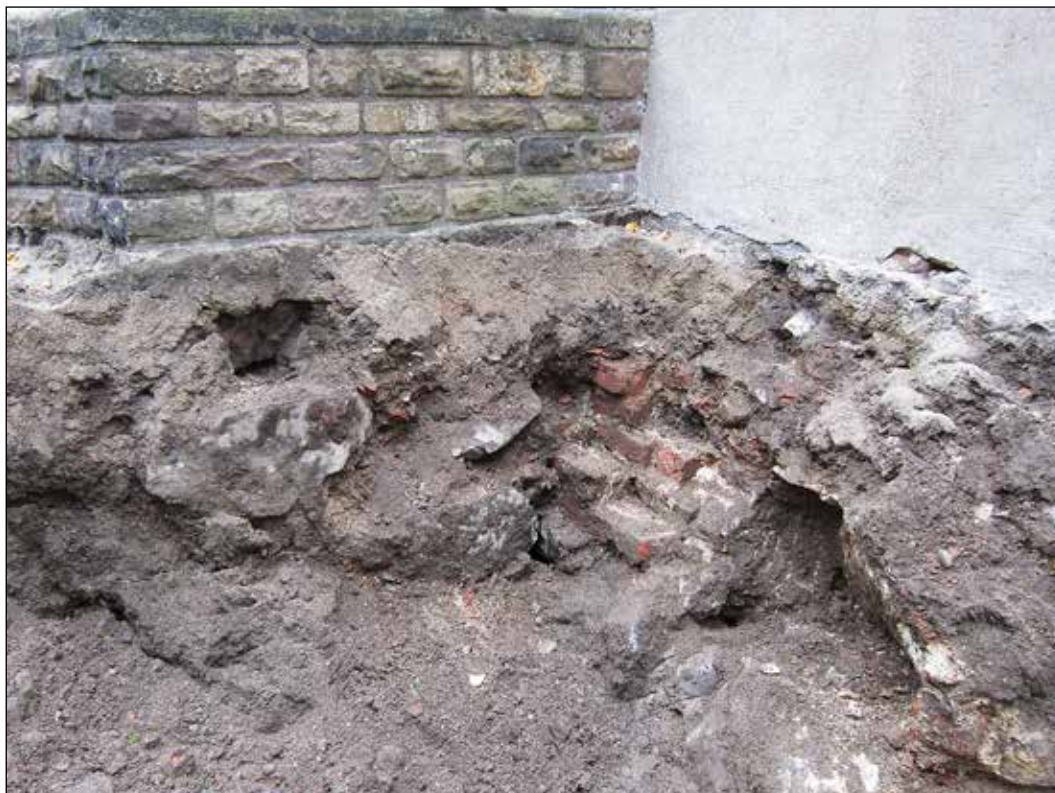
Figur 9. Rester av äldre tegelmur i grunden till Överkommissariens hus.
