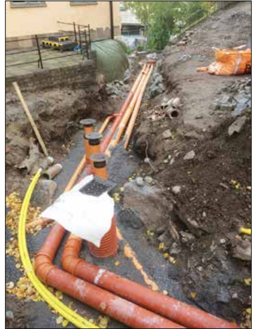
Figur 8. VA-schakt med nya installationer, sett från den högsta punkten i sydväst.
