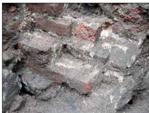
Figur 10. Närbild på muren i figur 9.
