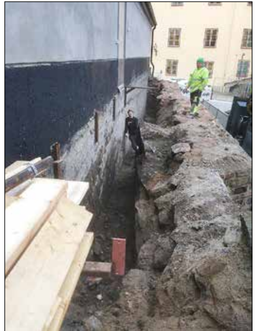
Figur 15. En allt bredare mur och naturligt berg gjorde att utrymmet var mycket begränsat längst ned.
