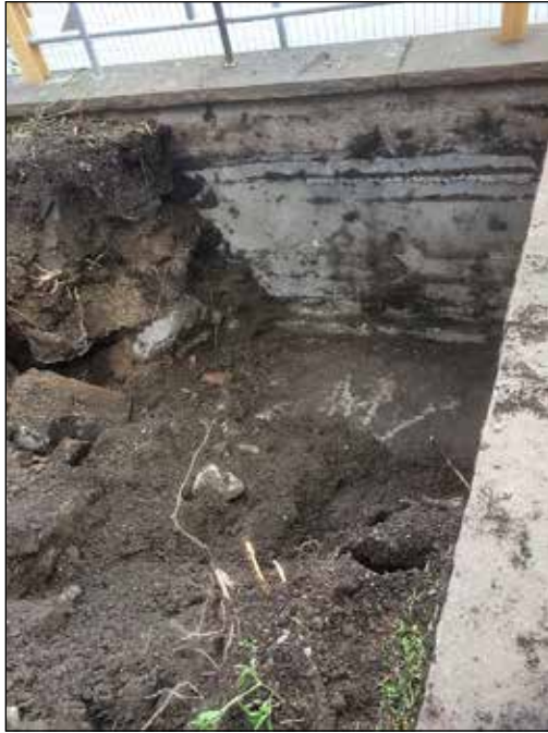
Figur 7. Grönytans nordöstra hörn. I botten syns betongkulverten och i bildens förgrund skymtar fast berg.
