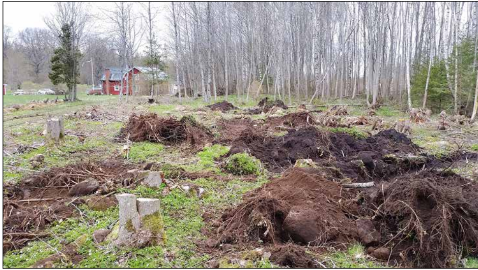
Figur 9. Schakten förlades där det var möjligt mellan stubbar och stenar. Foto från söder.
