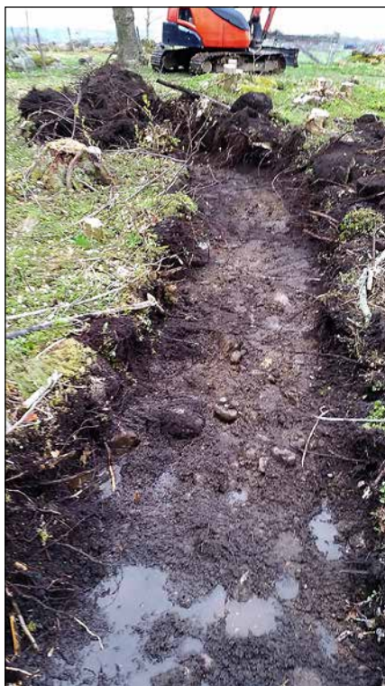
Figur 6. Schakten bestod överst av ett tunt lager med skogstorp som vid 0,1 meters djup övergick i grusig morän. I schakt 1 och 9 blev de östra ändarna av schakten vattenfyllda. Schakt 9 sett från öster.
