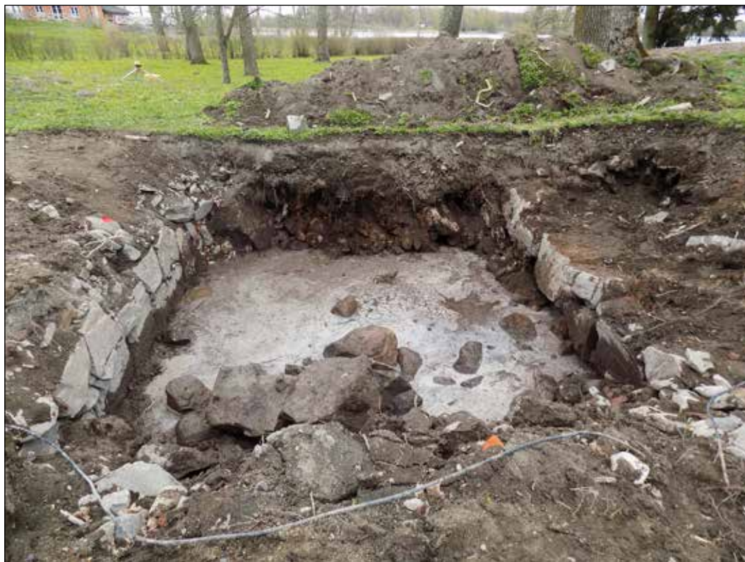
Figur 9. Kanalen delvis utgrävd med kantstenar synliga. Sett från väster.
