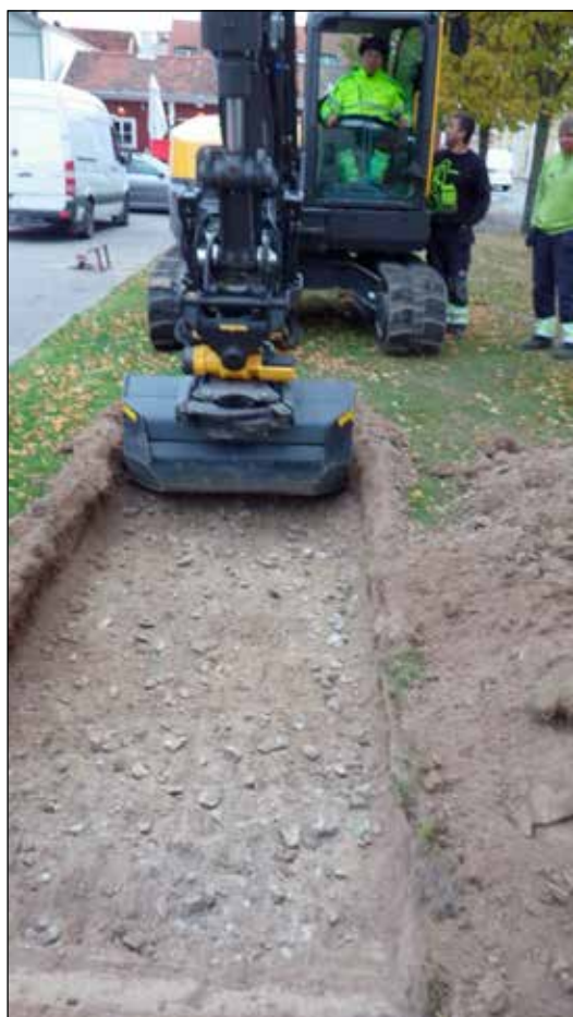
Figur 17. Förmedling erbjuds besökande som stannade till för att betrakta arbetet. De allra flesta var emellertid mest intresserade av att konversera med grävmaskinisten. Här vid schakt 200 i kvarteret Hatten.
