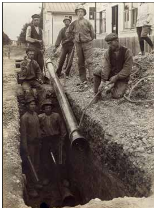
Figur 50. Arbete med vattenledningar i Lindesberg år 1905. Till vänster i bild syns Kristinavägen 43.
