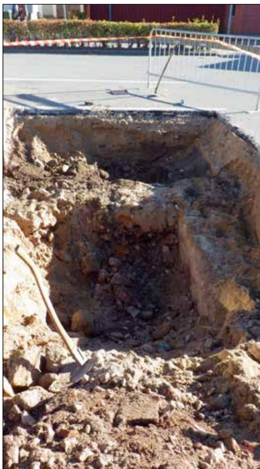
Figur 30. Lämningar efter en byggnad med gjuten betonggrund och källare, fylld med raseringsmassor. Schakt 700 i kvarteret Ängen.
