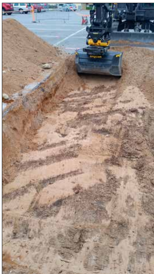
Figur 29. I kvartet Ängen utgjordes stratigrafin av ett tjockt bärlager av sand och grus som täckte den sterila leran eller odlingslagret där den påträffades. Här i schakt 500 syntes spår efter en tandad skopa som grävt ned till steril lera. Foto från söder.
