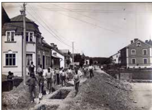
Figur 49. Foto som visar nedgrävning av vattenledningar längs Kristinavägen år 1905. Till höger i bild syns ännu stående byggnader på Kristinavägen 43 och 45.
