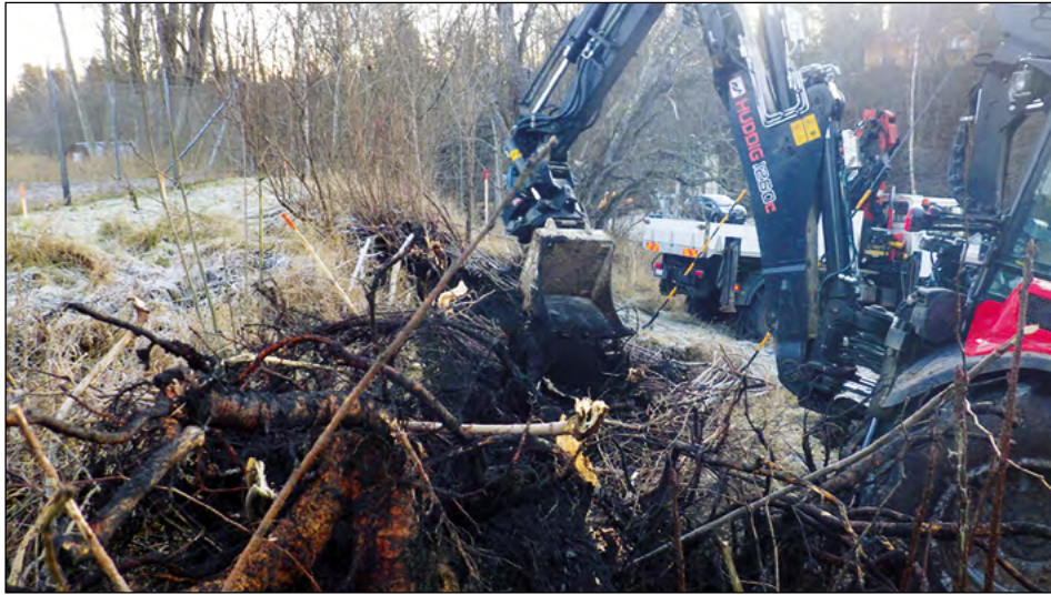
Figur 2. Röjning av buskar och ris i den branta slänten inför schaktning.
