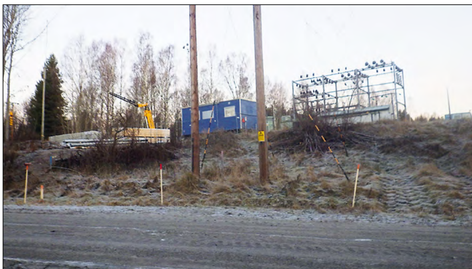
Figur 7. De stolpar som skulle bytas i det södra området. Foto från söder.
