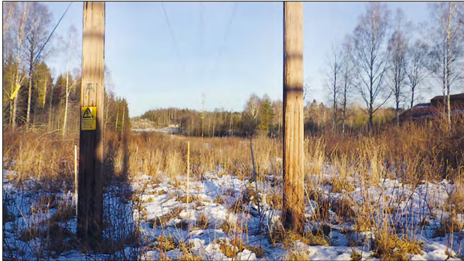
Figur 8. Det norra stolpparet som skulle bytas. Dessutom ses i bakgrunden den stolpe från vilken ett schakt grävdes mot söder för en jordlina. Foto från söder.
