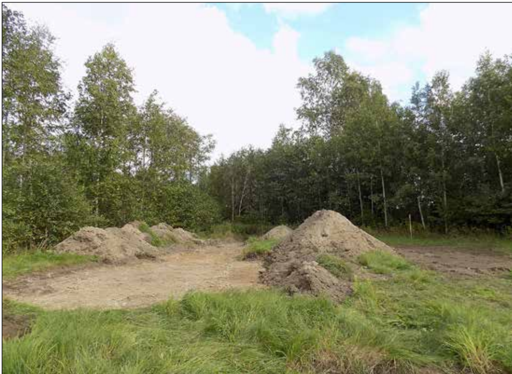
Figur 37. Översikt av den östra delen av objekt 30. Sett från väster.
