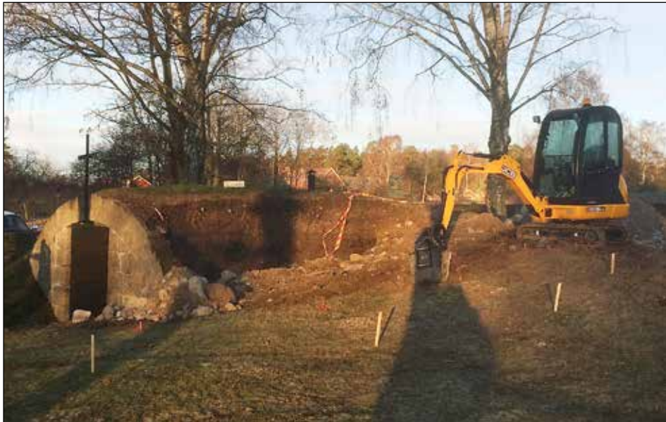
Figur 3. Schaktet intill kryptan.
