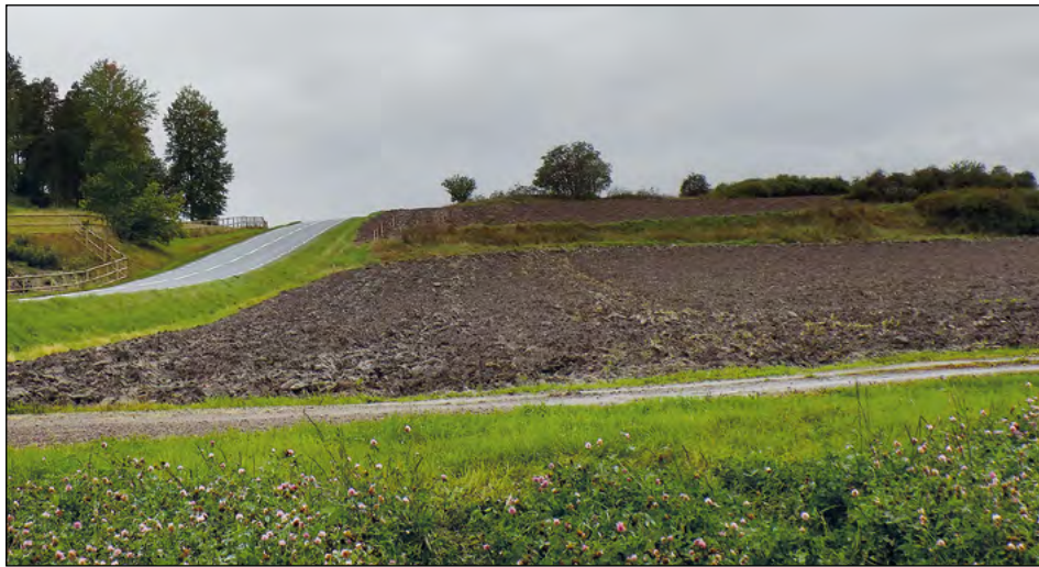
Figur 6. Översiktssbild över objekt 11 från öster.
