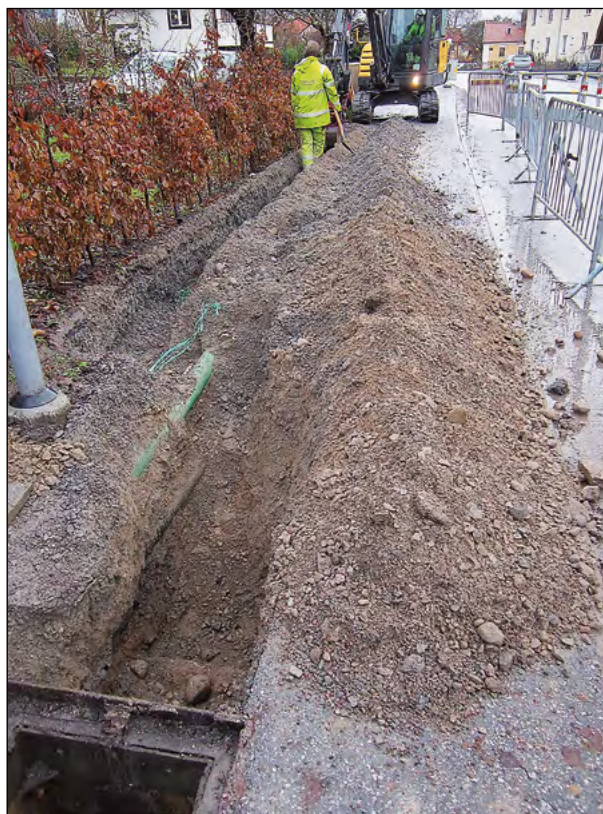
Figur 4. Schaktdelen i Prästgatan sedd från väster.
