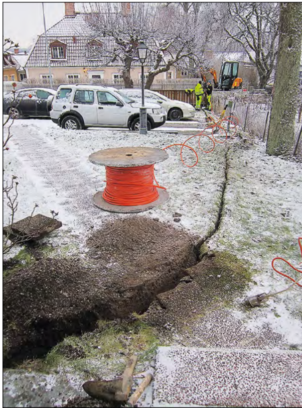
Figur 5. Schaktdelen genom trädgården sedd från norr.
