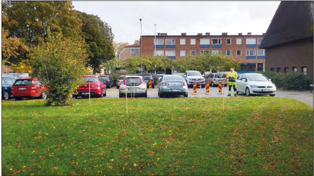
Figur 4. Undersökningsytan före schaktning. Foto från väster.
