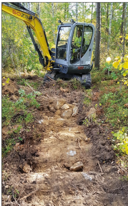
Figur 6. Ett av schakten under utgrävning. Marken bestod av sandig morän. Foto från nordöst av Leif Karlenby.
