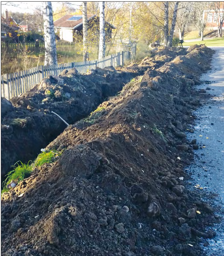
Figur. 4 Schaktet från från nordöst.
