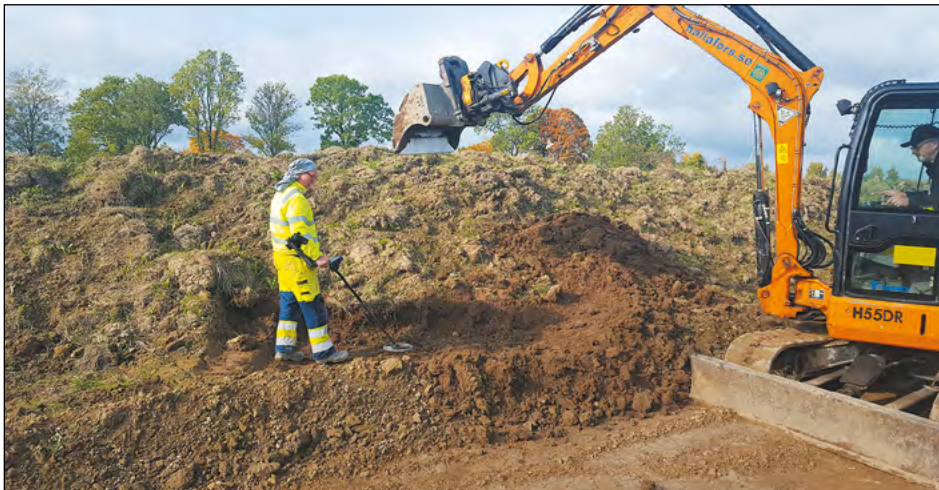
Figur 4. Nina undersöker dumpmassor upplagda utmed den västra kanten av utredningsområdet. Foto från öster.
