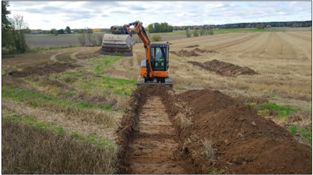
Figur 4. Utredningsgrävning pågår i utredningsområdets nordöstra del. Foto från nordväst.
