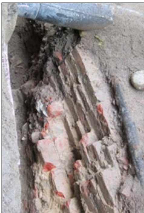
Figur 6. Exempel på mursektion, från den östra sidan.
