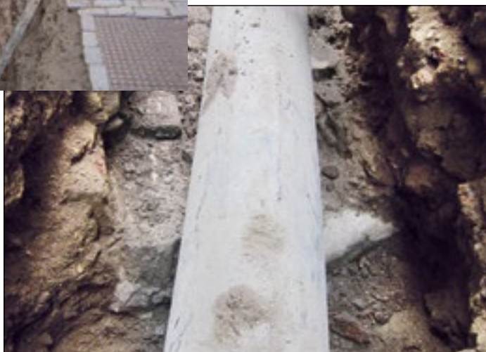
Figur 4. Befintligt rör med underliggande grundsten.
