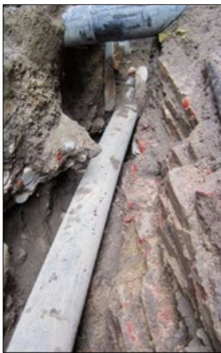
Figur 7. Där muren kröker mot väster.
