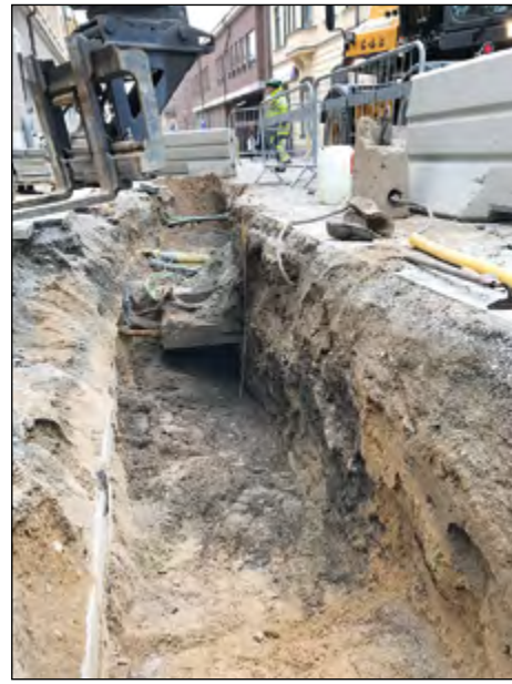
Figur 14. I den östra delen av korsningen fanns stora cementplattor. Jorden under sögs upp med sugbil. Foto från väster.
