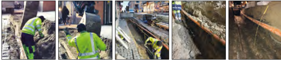
Figur 5. Översiktbilder från kvällsgrävningen. En äldre ledning som följde i schaktkanten försvårade ytterligare genom att skugga schaktväggen under.
