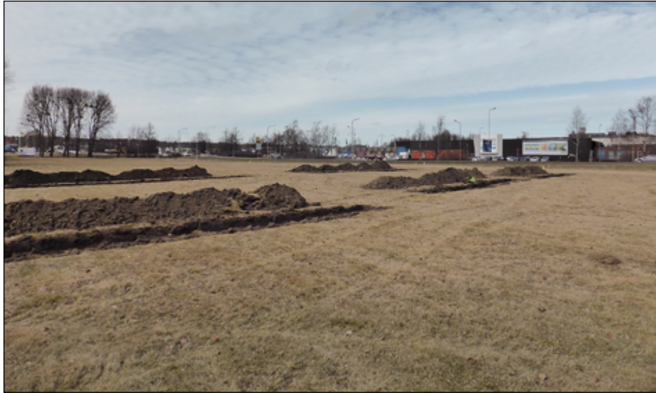
Figur 6. De första schakten har grävts i områdets östra del. Foto från sydväst.
