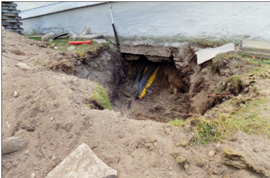
Figur 3. Foto av schakt 1, sett från norr.
