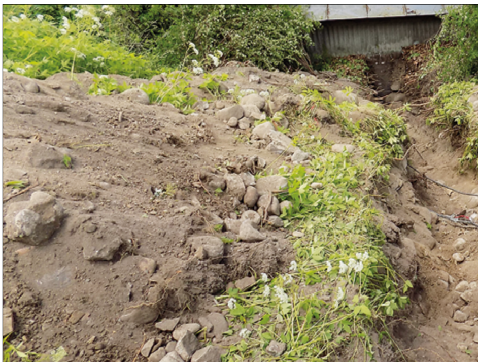
Figur 5. Schakt 2 med stenmassor i slänten, sett från öster.
